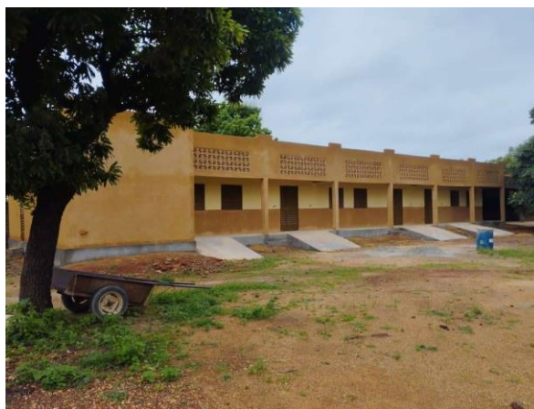
Le second bâtiment de l'école primaire comprend trois salles de classes et un magasin (sur la gauche de la photographie)
