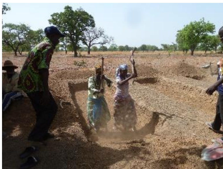
Photo : fonçage des fosses
