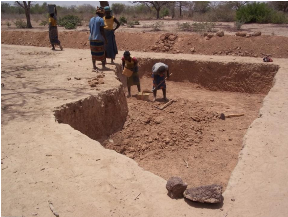
Creusement d'une mare. En arrière plan on aperçoit une diguette
